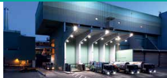
Müllheizkraftwerk Leverkusen | © Meinulf Seiffert
