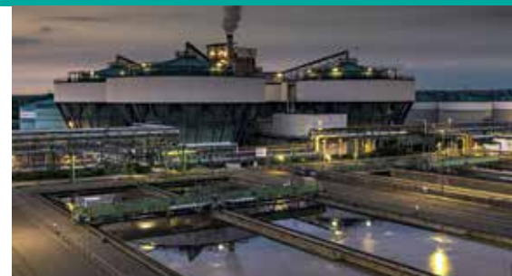
klärbecken und Turmbiologie des Entsorgungszentrums in Leverkusen-Bürrig © Currenta
